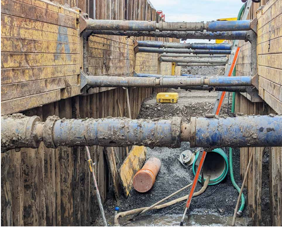
Grabarbeiten für die Gemeindeleitung in der Bahnhofstrasse des Kantons.
