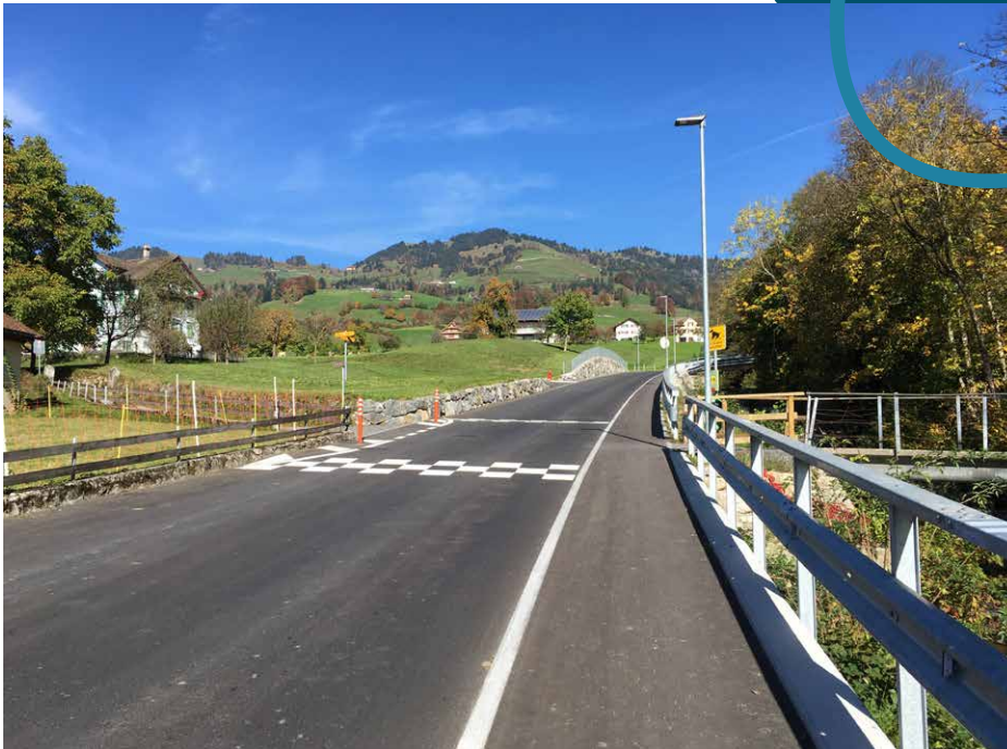
Die ausgebaute Nietenbachstrasse.
