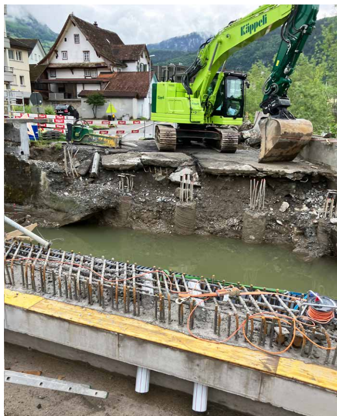
Neue Tobelbachbrücke in Ibach im Bau.
