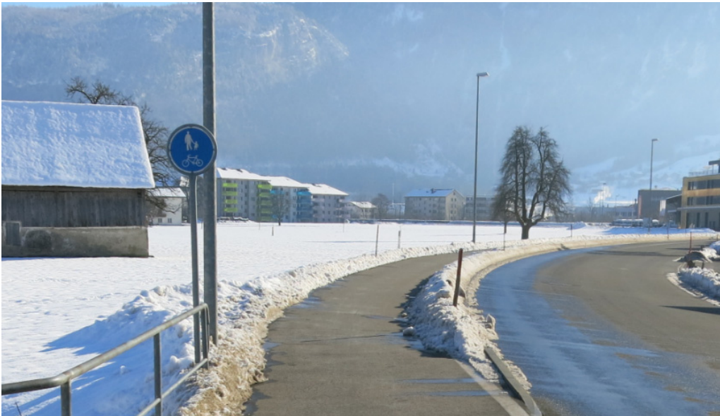
Abbildung 21: Bestehender Rad-/Gehweg Wintersried
