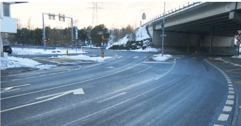
Abbildung 18: Fehlende Querungshilfe für den Veloverkehr
